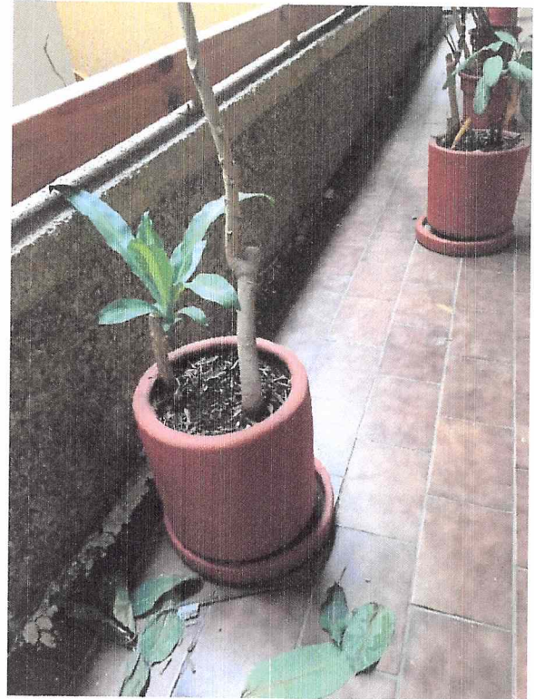
DESPRENDIMIENTO DE PRETEL DE PASILLO DE LA LOSA DE ENTREPISO
