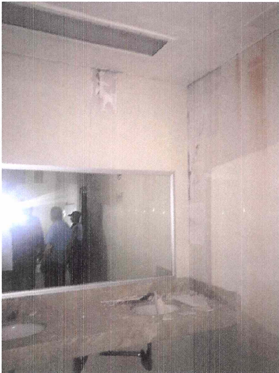
DESPRENDIMIENTO DE RECUBRIMIENTO DE MUROS DE TABIQUE EN ZONA DE BAÑOS Y VESTIDORES
