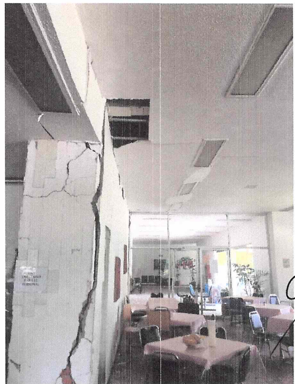
DESPRENDIMIENTO DEL RECUBRIMIENTO DE LA ESTRUCTURA YA QUE A SIMPLE VISTA ESTE NO SE ENCUENTRA ANCLADO A LA MISMA
