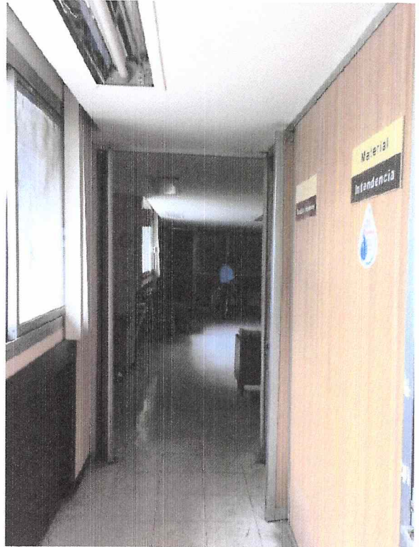
LAS ÁREAS DE CIRCULACIÓN DE LA ZONA ADMINISTRATIVA NO MUESTRAN DAÑO
