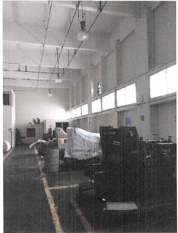
LA ESTRUCTURA PRINCIPAL DEL EDIFICIO, VIGAS Y COLUMNAS NO MUESTRAN GRIETA ALGUNA
