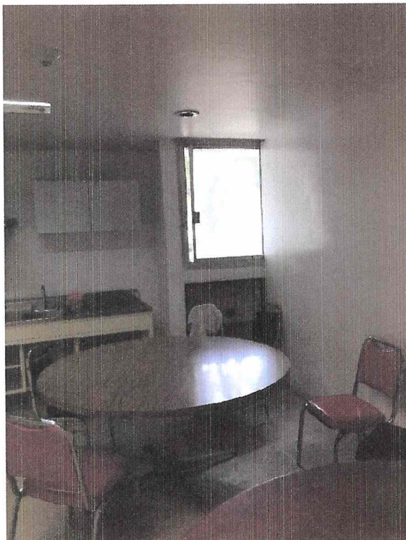
LOS MUROS Y PLAFONES E INSTALACIONES HIDROSANITARIAS Y ELÉCTRICAS NO PRESENTAN DAÑO ALGUNO A SIMPLE VISTA
