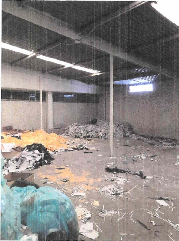
LA ESTRUCTURA PRINCIPAL DEL EDIFICIO, VIGAS Y COLUMNAS NO MUESTRAN GRIETA ALGUNA
