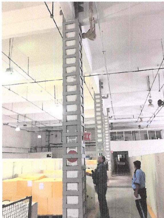
LA REESTRUCTURACIÓN QUE TIENE LA ESTRUCTURA PRINCIPAL NO SE VE AFECTADA
