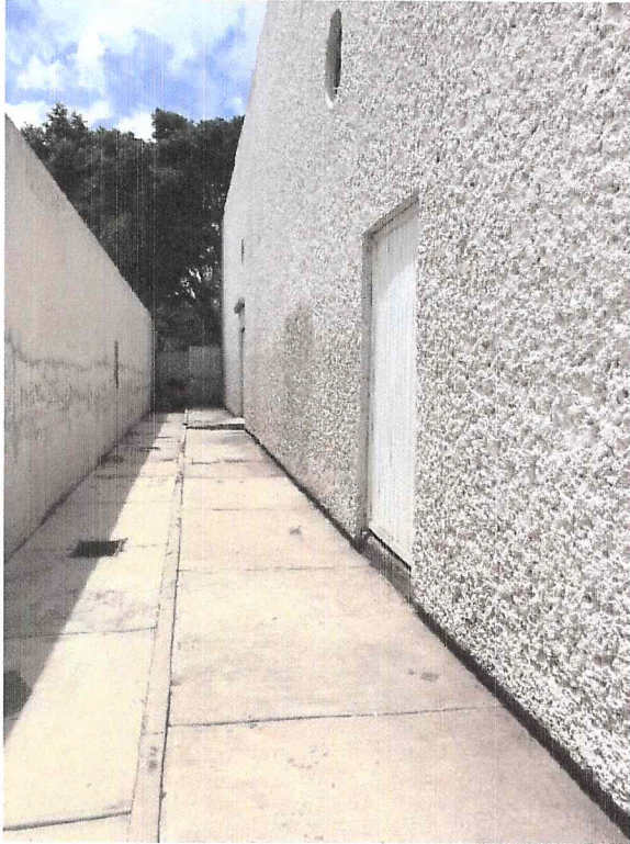
LOS MUROS EXTERIORES A SIMPLE VISTA NO PRESENTAN GRIETAS DE CONSIDERABLES
