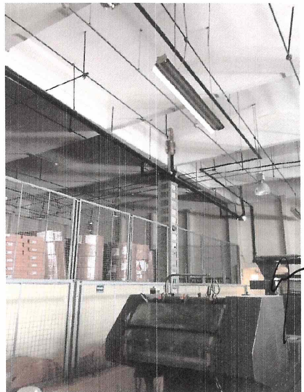
LAS INSTALACIONES NO MUESTRAN DAÑO ALGUNO.
