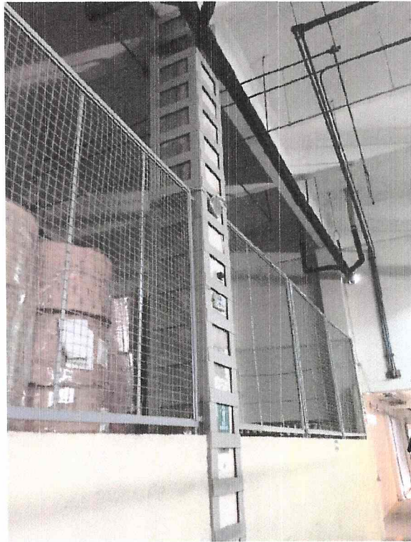
A SIMPLE VISTA LAS REESTRUCTURACIONES DEL EDIFICIO NO SUFRIERON ALTERACIÓN ALGUNA
