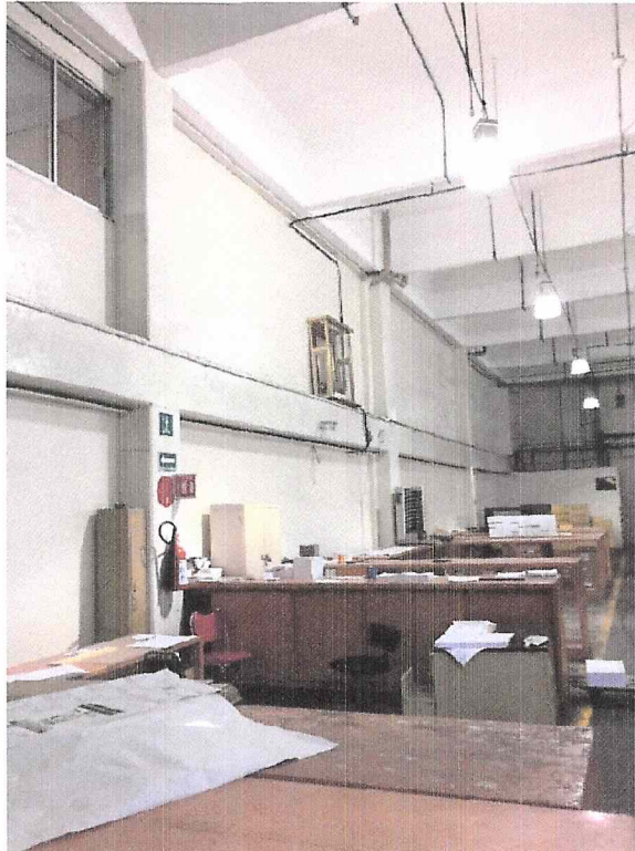
A LAS INSTALACIONES ELÉCTRICAS NO SE LES NOTA DAÑO ALGUNO
