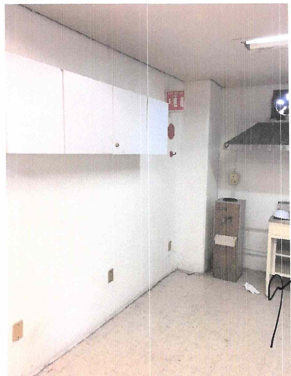
LAS ÁREAS DE COMEDOR PRESENTAN MUROS Y PLAFONES SANOS
