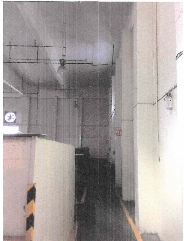
LA ESTRUCTURA PRINCIPAL DE LA NAVE A SIMPLE VISTA NO MUESTRA DAÑO ALGUNO
