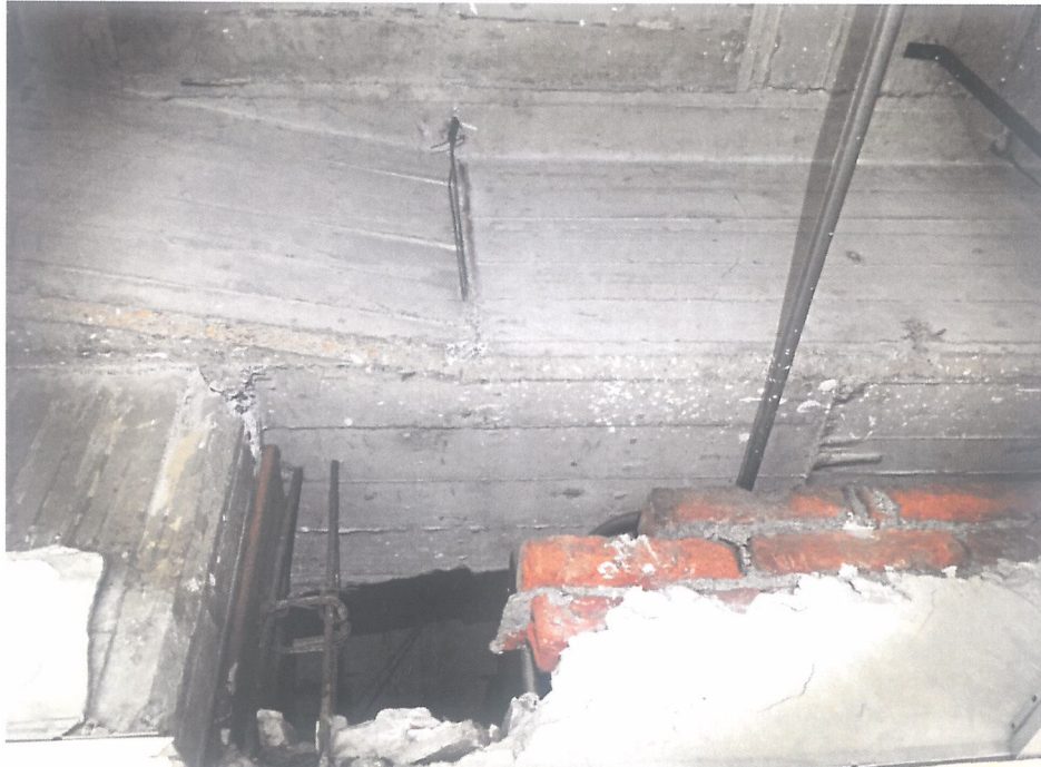
Figura 3, sistema de marcos ortogonales de concreto reforzado
