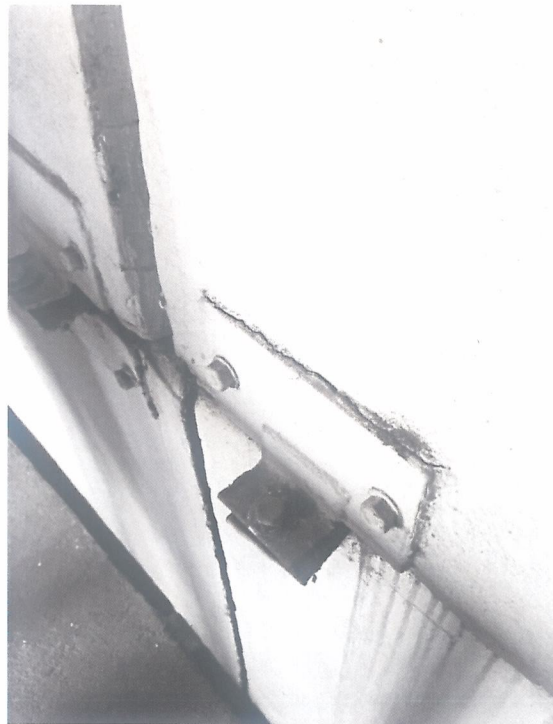
Figura 7, sistema de anclaje y conexión de fachada
