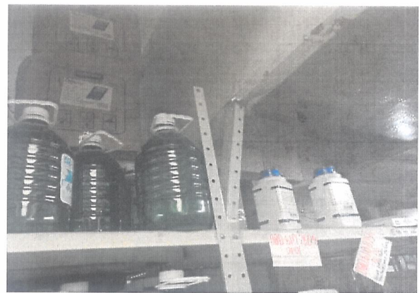
trabe de concreto comprimiendo anaquel en zona de bodega.
