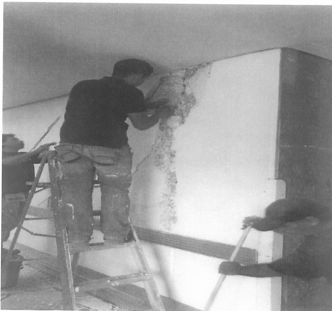
Retiro de aplanado para observar fisura
