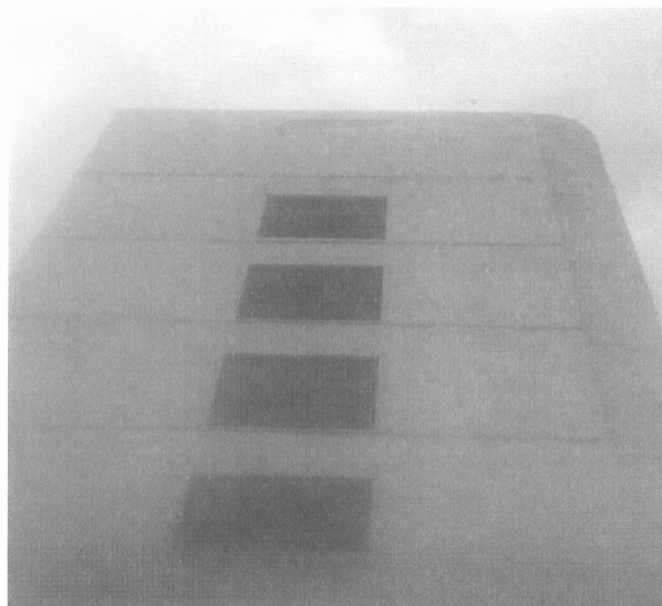
Fachada sin problema de acabado
