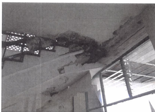
Cuerpo 3, "Centro de Seguridad Social", las escaleras se encuentran dañada estructuralmente
