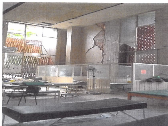
Cuerpo 3, "Centro de Seguridad Social", en planta baja área de doble altura se desprendió azulejo en muros
