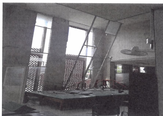
Cuerpo 3, en planta baja área de doble altura la herrería se desprendió de losa a piso
