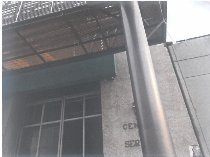
Figura 3, Fachada del inmueble
