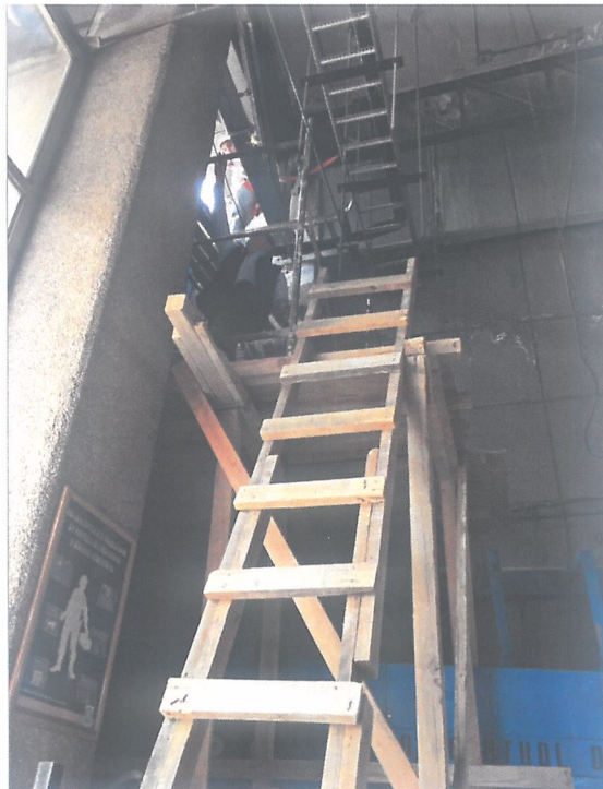
Figura 6, trabajos de reparación en fachada, llevados a cabo por personal interno del instituto
