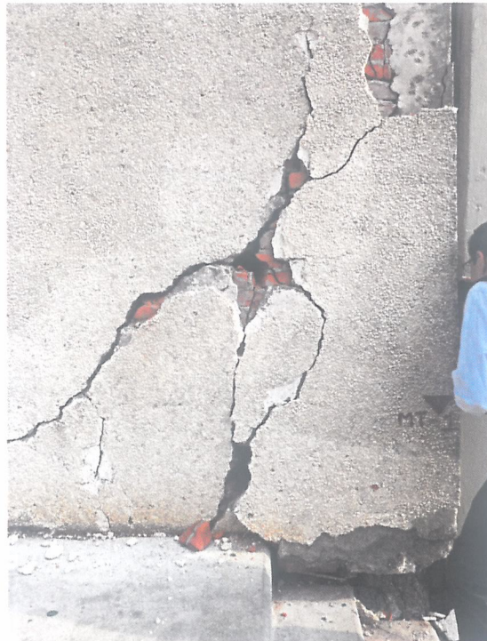
Figura 4, Muro con elementos prefabricados de concreto y sujetos a mampostería del inmueble.
